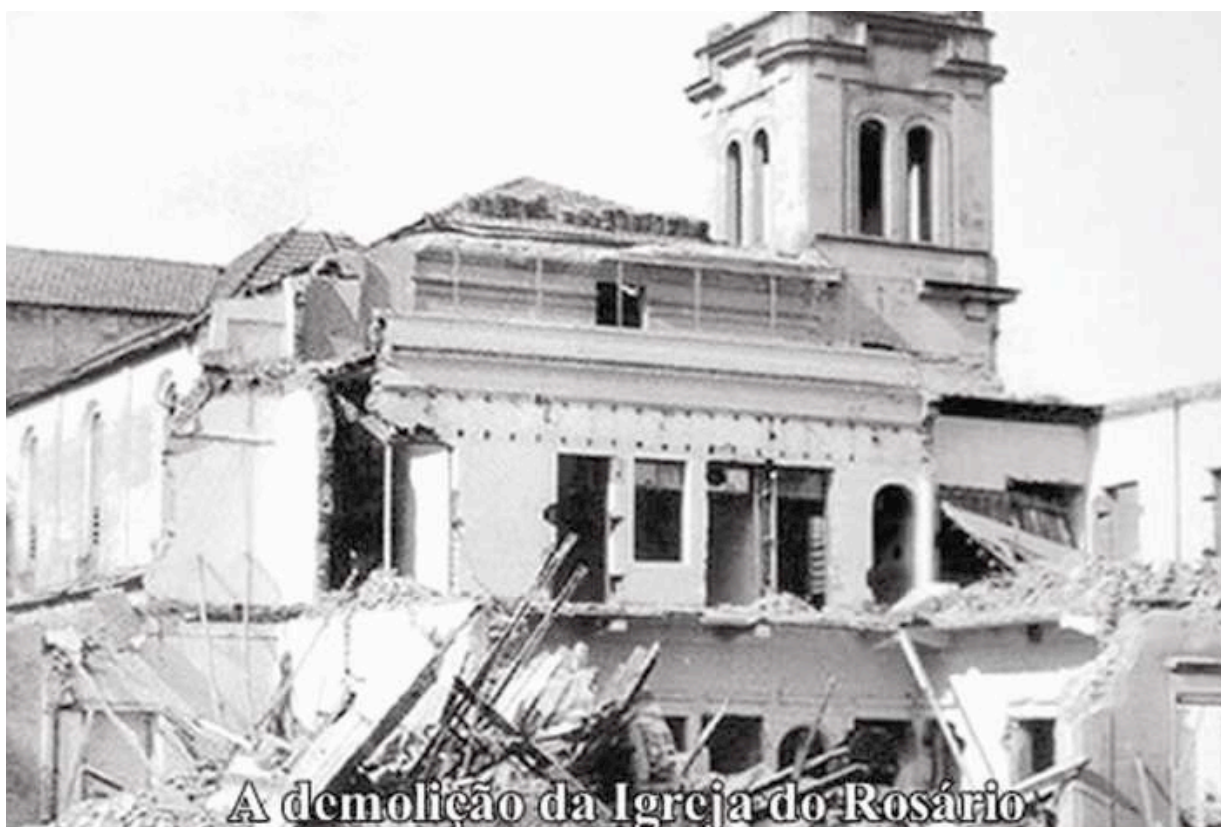
Figura 3 Demolição da Igreja do Rosário 1956.
