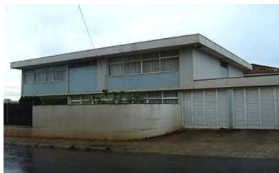
Figura 13: Residência na Rua Floriano Peixoto. Vista Lateral. Fonte: Acervo dos autores, 2011
