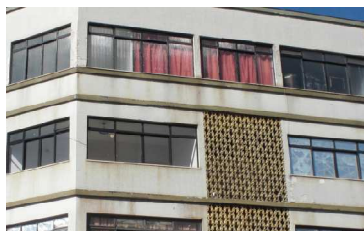
Figura 19: Detalhe das janelas em fita, da emolduração dos pavimentos e do cobogó na parte central destinada a circulação. Fonte: acervo dos autores, 2011.
