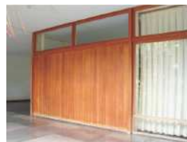
Figura 5: Painel em Madeira como divisória em residência atribuída ao escritório de Oscar Niemeyer. Fonte: Lima, Camila Loiola, 2011.
