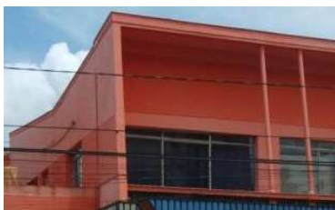
Figura 18: Detalhe do telhado borboleta, da "moldura" da fachada e varanda com pilares circulares. Fonte: acervo dos autores, 2011.
