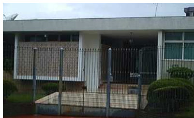
Figura 12: Residência na Rua Floriano Peixoto. Vista Lateral. Fonte: Acervo dos autores, 2011.
