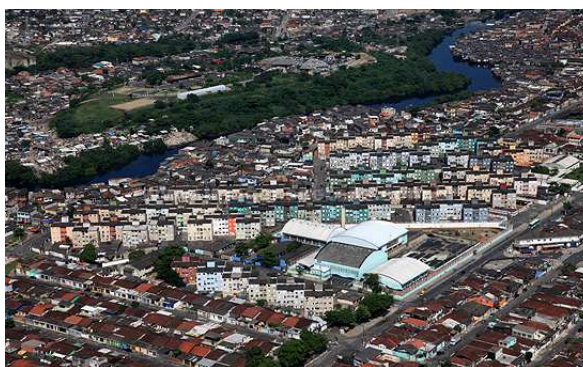
Figura 11: Conjunto Dale Coutinho - Cohab-Santos/SP, 1981. (11) Foto aérea. In Imagens Aéreas – Banco de Imagens da Baixada Santista. Fonte: www.imagensaereas.com.br . Acesso em 13 de junho de 2012;
