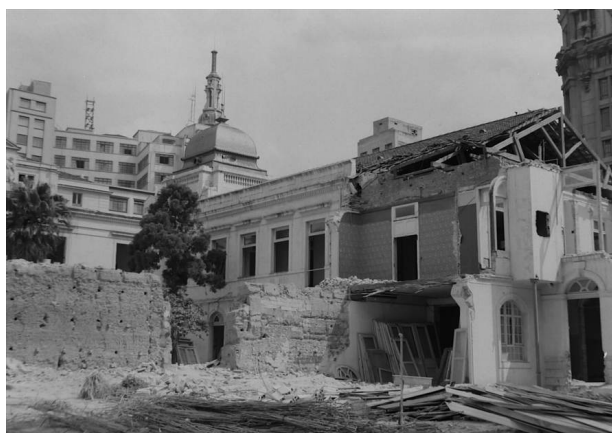
Figura 02 – Processo de demolição da Secretaria de Educação – antigo Pátio do Colégio – em 1953. Fonte: Sebastião A. Ferreira – Arquivo Histórico de São Paulo
