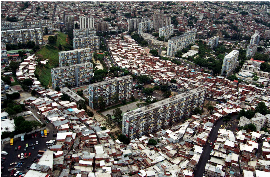
Figura 8: Urbanización 23 Enero. Projeto de Carlos Raúl Villanueva, Carlos Celis Cepero e equipe.
