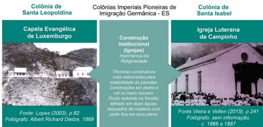
Figura 6 – Desenvolvimento – Construção Institucional – Final do século XIX e início do século XX Fonte: Elaborado pelas autoras.
