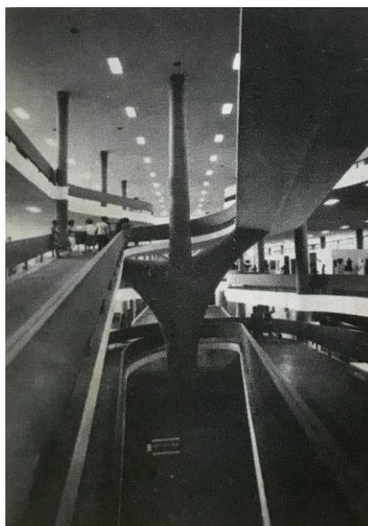
Figura 15 - Rampa do Palácio da Indústria, Parque Ibirapuera
