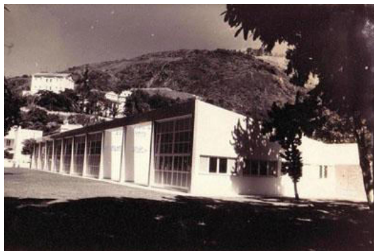
Figura 5 – Vista parcial do Jardim de Infância Ernestina Pessoa, no Parque Moscoso.
