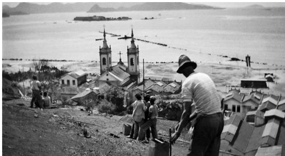
Figura 4 - Desmorte do Morro do Castello, ao fundo pode-se ver a Igreja de Santa Luzia ainda a beira do mar - Julio Ferrez - 1921
