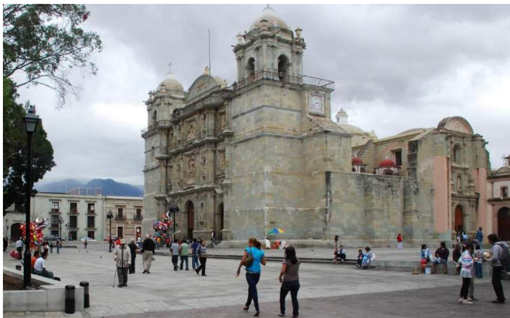
Figura 23 – Catedral de Nuestra Señora de la Asunción da antiga Antequera de Oaxaca – iniciada em 1535, mas reconstruída no século XVIII após um forte sismo. Apresenta-se voltada de lado para um dos setores da Plaza de Armas. Fonte: Fotografia do autor, 2009.
