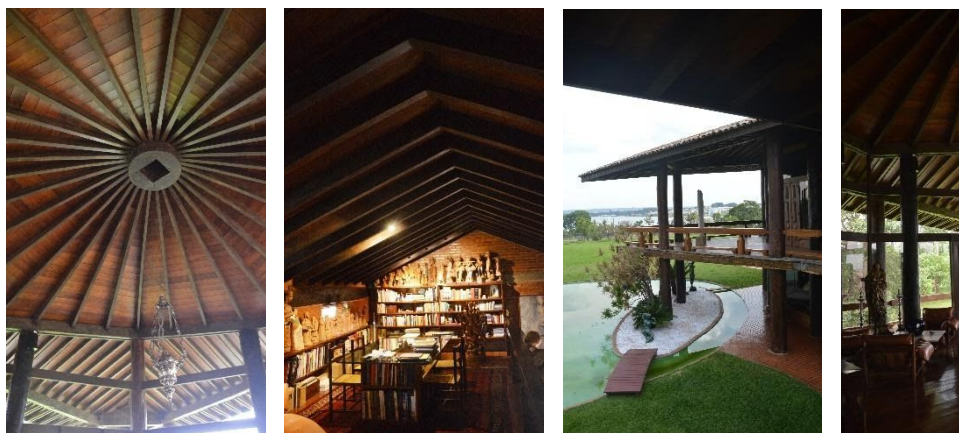
Figura 13: Detalhes de forros internos e dos beirais. Fonte: Elaborado pela autora.
