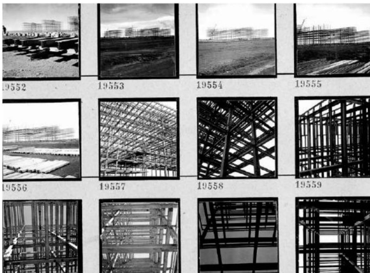
Figura 7: Marcel Gautherot. Prancha-contato com os detalhes dos Ministérios em construção.
